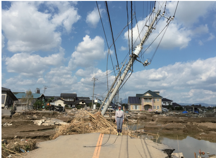
平成27年2月 鬼怒川水害調査(茨城県常総市)
