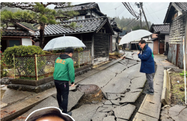
穴水町でのマンホール浮上(1月3日)
