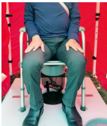
マンホールトイレ
